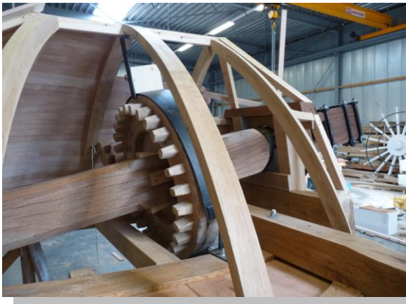
De molenkap met azobe-as en bovenwiel...
