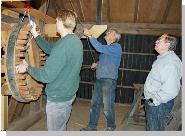
De onderbonkelaar wordt gepositioneerd.
