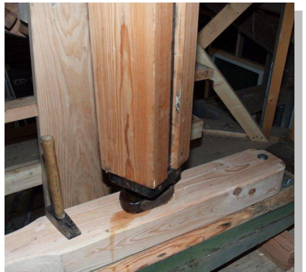
De taats waarop de koningsspil rust
