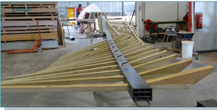
De molenkap met azobe-as en bovenwiel...
