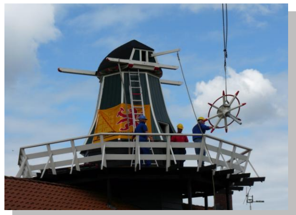
... en het kruirad bevestigd.
