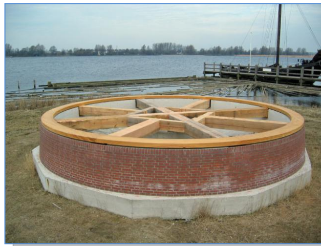
Ringmuur met zwaarden, kruisbalken en kruivloer
